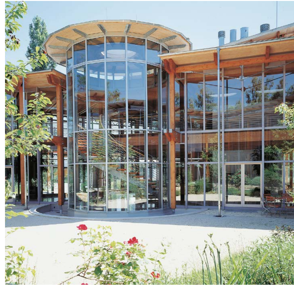
LUXHAUS Verwaltungsgebäude in Georgensgmünd, ausgezeichnet mit dem europäischen Holzpreis 1994.
